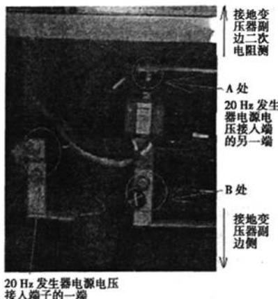
20 Hz 发电机电源电压接入端子的一端
